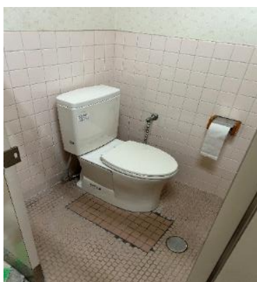
▲改修完成写真(和式から洋式へ)
